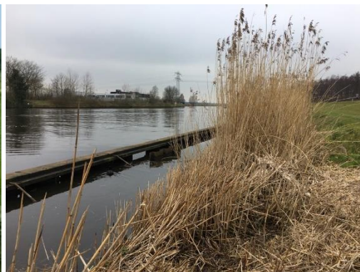
Foto 4 (bestaande situatie damwand)
